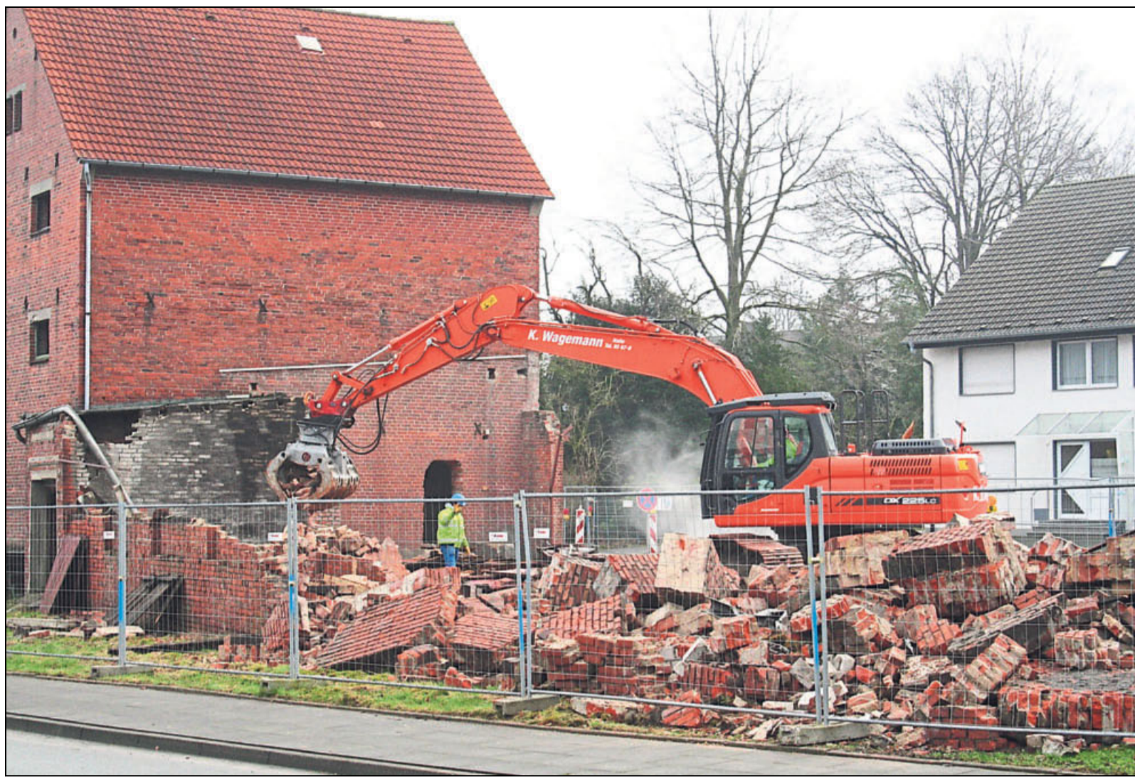
Das Größte ist erledigt: Der Bagger hat den früheren Land- und Kohlenhandels Rüter am Kleinbahnhof platt gemacht. Das Gelände zwischen Enger- und Gartenstraße wird für die Firma »Bauidee Werther« freigeräumt. Sie plant dort einen Neubau. Foto: Freya Schlottmann
